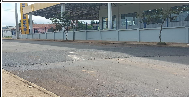
12 | Rua Cel. Tirburcio Cavalcante - faixa elevada
