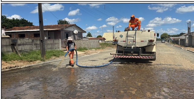
19 | Rua Afonso Pena - limpeza de pista
