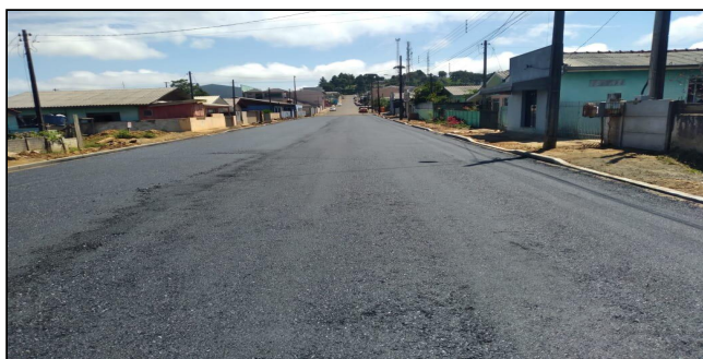
21 | Rua Afonso Pena - reperfilamento
