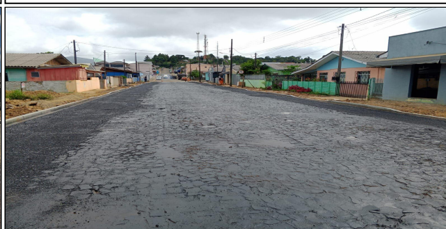
20 | Rua Afonso Pena - pintura de ligação
