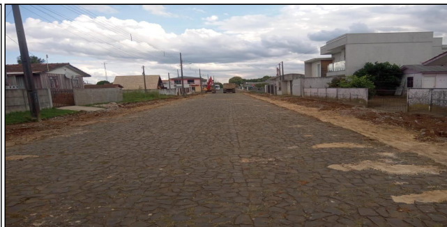
14 | Rua Afonso Pena - remoção de meio fio
