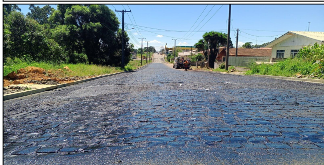
7 | Rua Cel. Tirburcio Cavalcante - pintura de ligação
