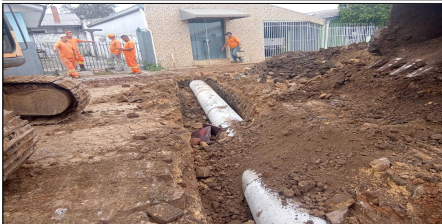
15 | Rua Afonso Pena - drenagem pluvial - tubos
