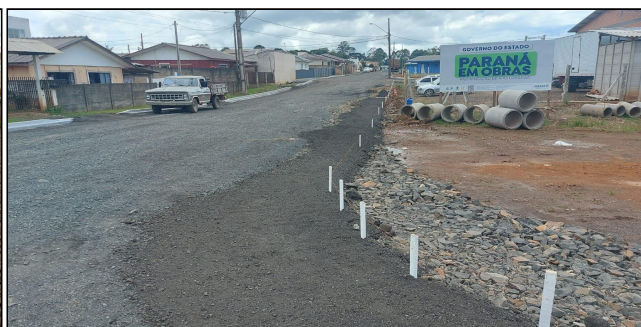
14 | Rua Genauro Pacheco Gomes - locação de meio fio
