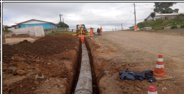
8 | Rua Genauro Pacheco Gomes - drenagem pluvial ala de concreto
