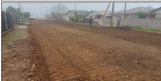
11 | Rua Genauro Pacheco Gomes - regularização e compactação de subleito
