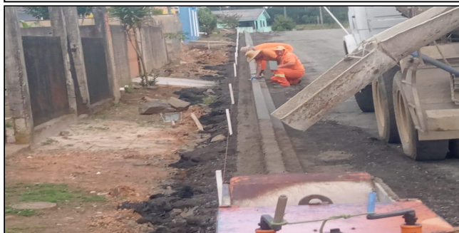
15 | Rua Genauro Pacheco Gomes - meio fio em concreto
