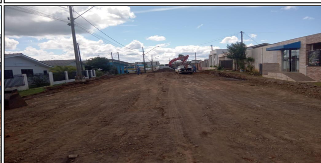
10 | Rua Genauro Pacheco Gomes - regularização e compactação de subleito
