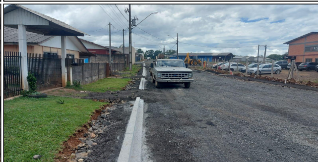
16 | Rua Genauro Pacheco Gomes - meio fio em concreto
