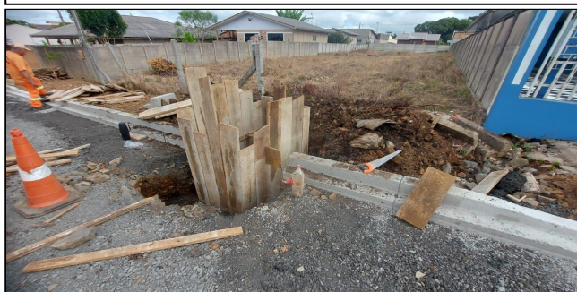
19 | Rua Genauro Pacheco Gomes - boca de lobo
