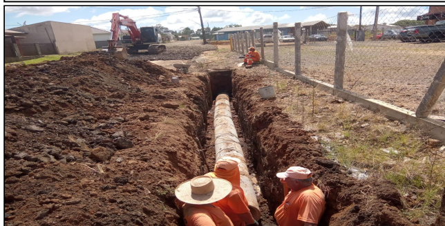
7 | Rua Genauro Pacheco Gomes - drenagem pluvial - tubos
