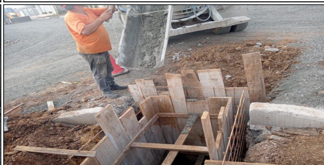
18 | Rua Genauro Pacheco Gomes - boca de lobo
