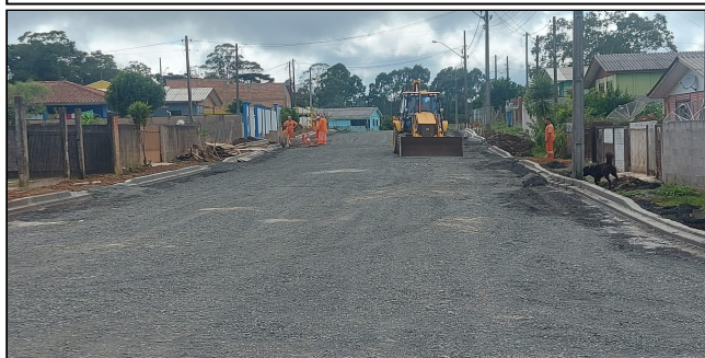
17 | Rua Genauro Pacheco Gomes - meio fio em concreto
