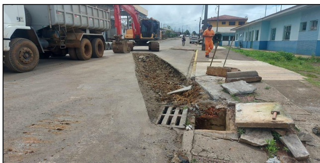
5 | Rua Cel. Tirburcio Cavalcante - drenagem pluvial - Escavação de valas
