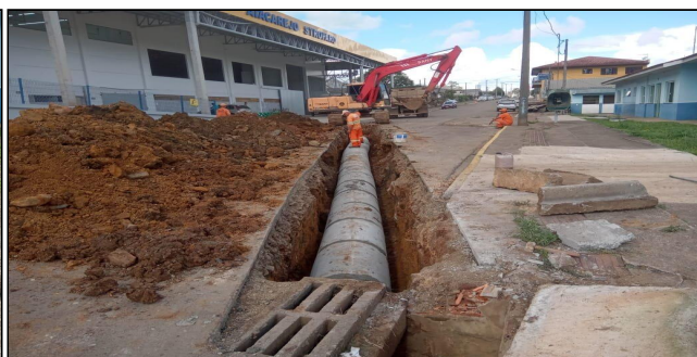
6 | Rua Cel. Tirburcio Cavalcante - drenagem pluvial - tubos
