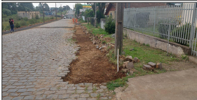
15 | Rua Cel. Tirburcio Cavalcante - locação de meio fio em concreto
