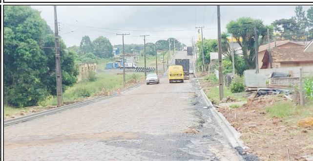
20 | Rua Cel. Tirburcio Cavalcante - meio fio em concreto
