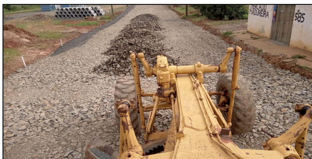
13 | Rua Cel. Tirburcio Cavalcante - Sub base em macadame
