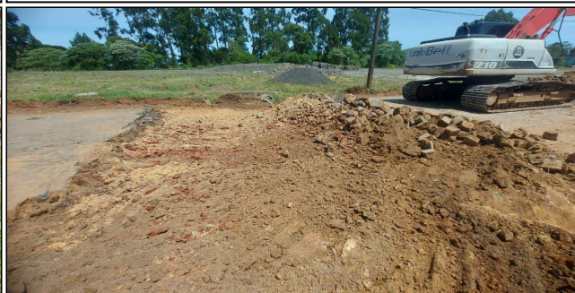
8 | Rua Cel. Tirburcio Cavalcante - retirada de pavimento existente
