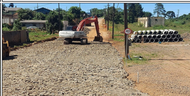
12 | Rua Cel. Tirburcio Cavalcante - Sub base em macadame
