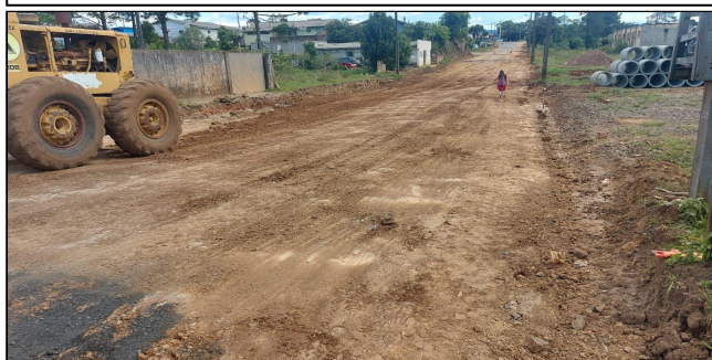
11 | Rua Cel. Tirburcio Cavalcante - regularização e compactação
