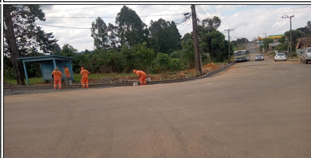
18 | Rua Cel. Tirburcio Cavalcante - meio fio em concreto
