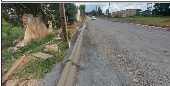
19 | Rua Cel. Tirburcio Cavalcante - meio fio em concreto
