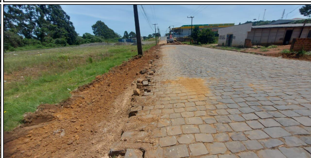
10 | Rua Cel. Tirburcio Cavalcante - retirada de meio fio existente
