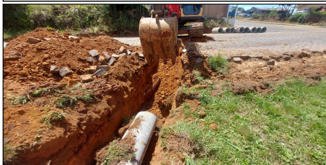
7 | Rua Cel. Tirburcio Cavalcante - drenagem pluvial - tubos
