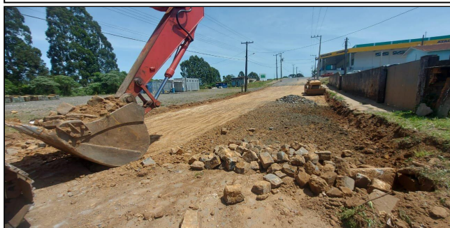
9 | Rua Cel. Tirburcio Cavalcante - retirada de pavimento existente
