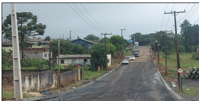
21 | Rua Cel. Tirburcio Cavalcante - meio fio em concreto
