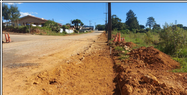
16 | Rua Cel. Tirburcio Cavalcante - locação de meio fio em concreto
