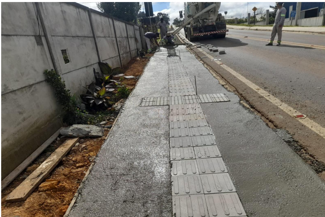
Imagem 04 – Concretagem das calçadas
