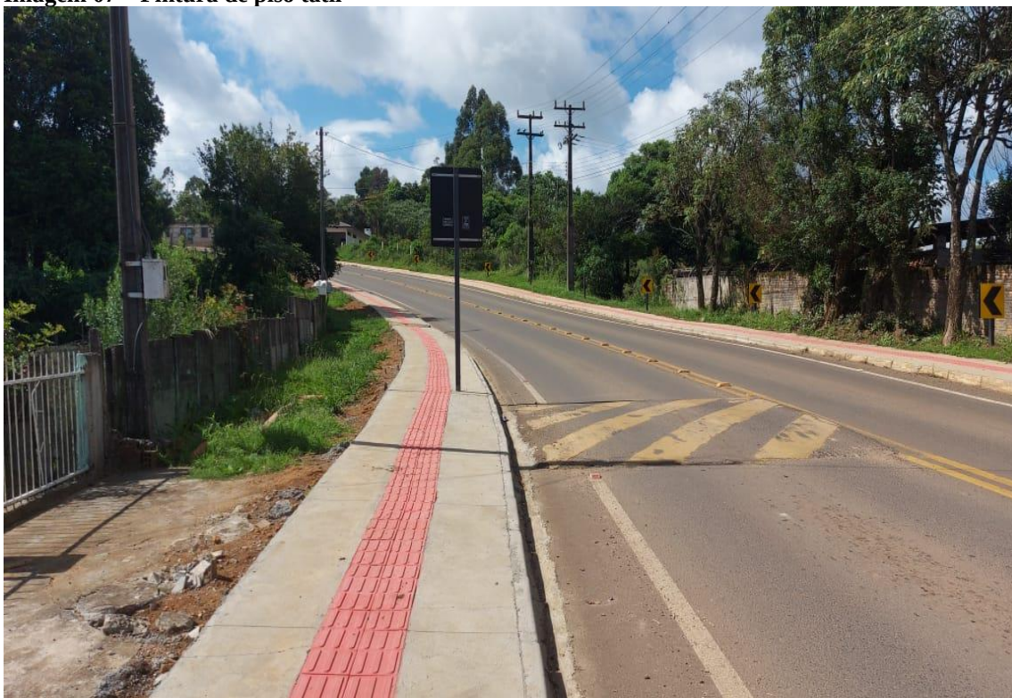
Imagem 07 – Pintura de piso tátil
