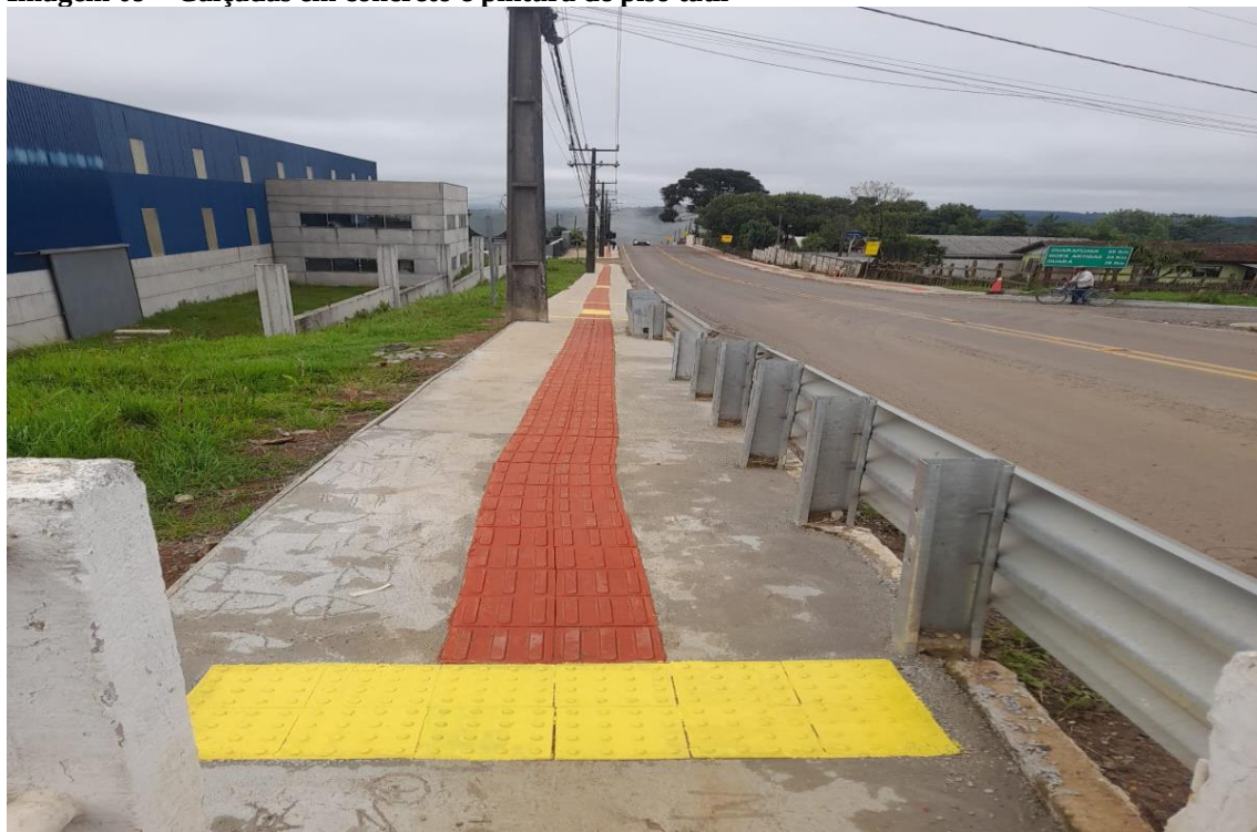
Imagem 10 – Calçadas em concreto e pintura de piso tátil
