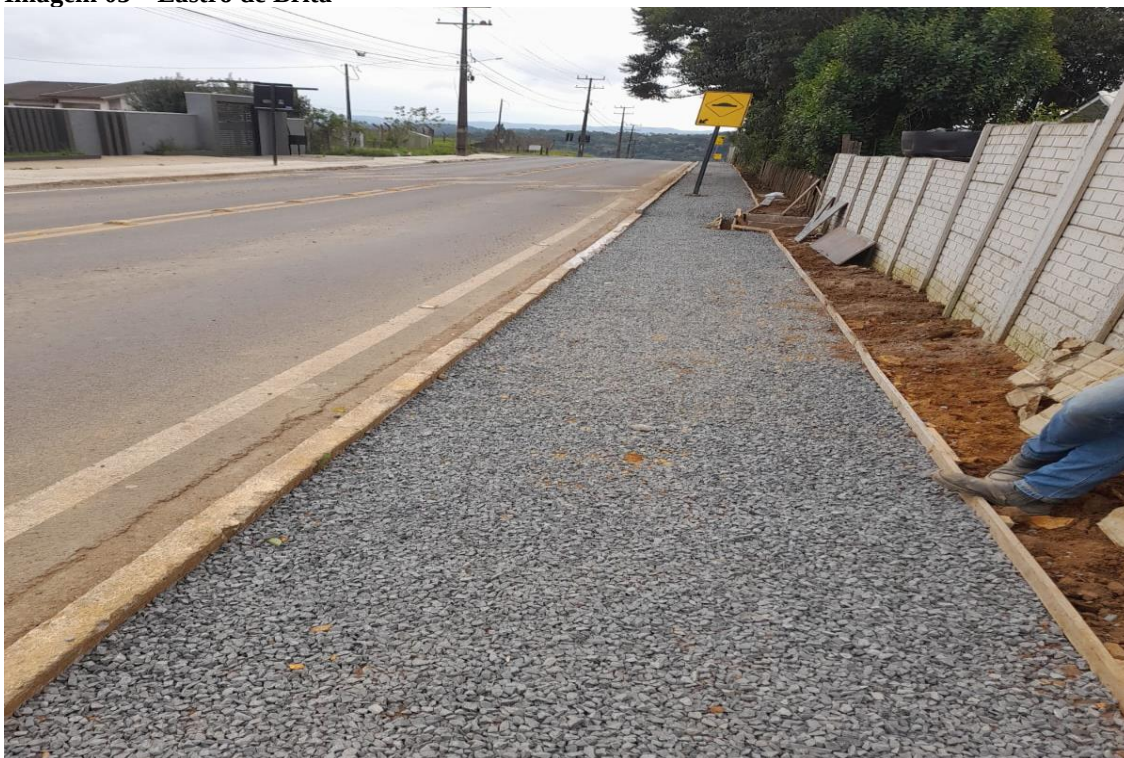
Imagem 03 – Lastro de Brita
