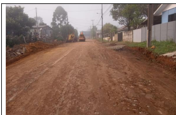
15 – RUA OSVALDO MIKETEN – REGULARIZAÇÃO E COMPACTAÇÃO DE SUB LEITO
