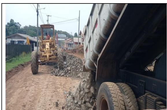
16 – RUA NADIR OSVALDO MIKETEN – SUB BASE EM MACADAME SECO
