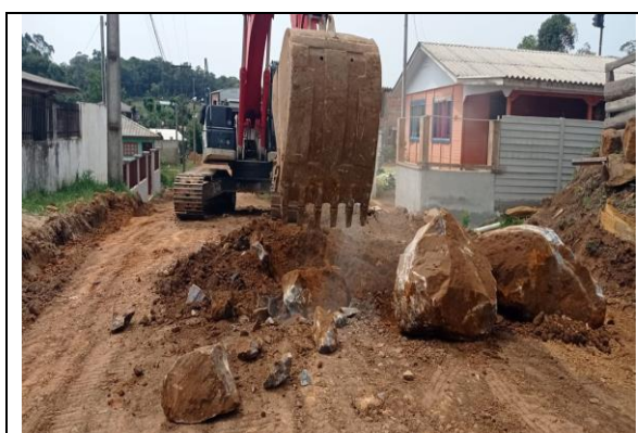
11 – RUA OSVALDO MIKETEN – ESCAVAÇÃO DE VIA
