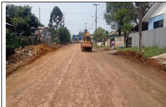
14 – RUA OSVALDO MIKETEN – REGULARIZAÇÃO E COMPACTAÇÃO DE SUB LEITO
