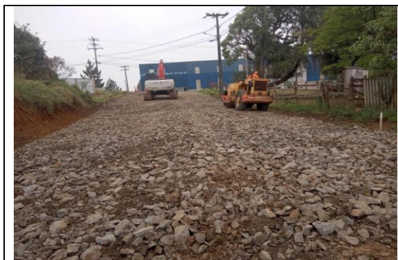
18 – RUA NADIR OSVALDO MIKETEN – SUB BASE EM MACADAME SECO
