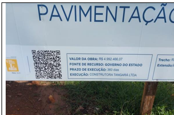
2 – RUA NADIR OSVALDO MIKETEN - DETALHE DA PLACA DA OBRA (QR CODE)
