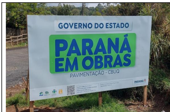
1 – RUA NADIR OSVALDO MIKETEN - DETALHE DE PLACA DA OBRA ATUALIZADA
