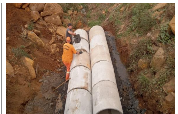
9 – RUA NADIR OSVALDO MIKETEN - TUBO DN 80 CM - ARMADO
