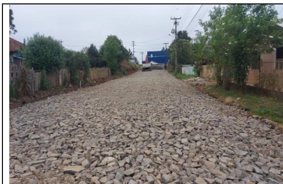
17 – RUA NADIR OSVALDO MIKETEN – SUB BASE EM MACADAME SECO
