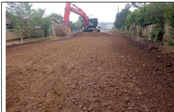
13 – RUA OSVALDO MIKETEN - ESCAVAÇÃO DE VIA
