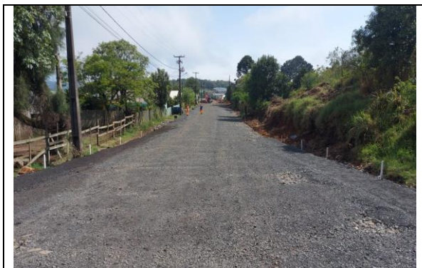
19 – RUA NADIR OSVALDO MIKETEN – SUB BASE EM MACADAME SECO
