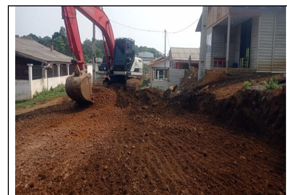
12 – RUA NADIR OSVALDO MIKETEN - ESCAVAÇÃO DE VIA
