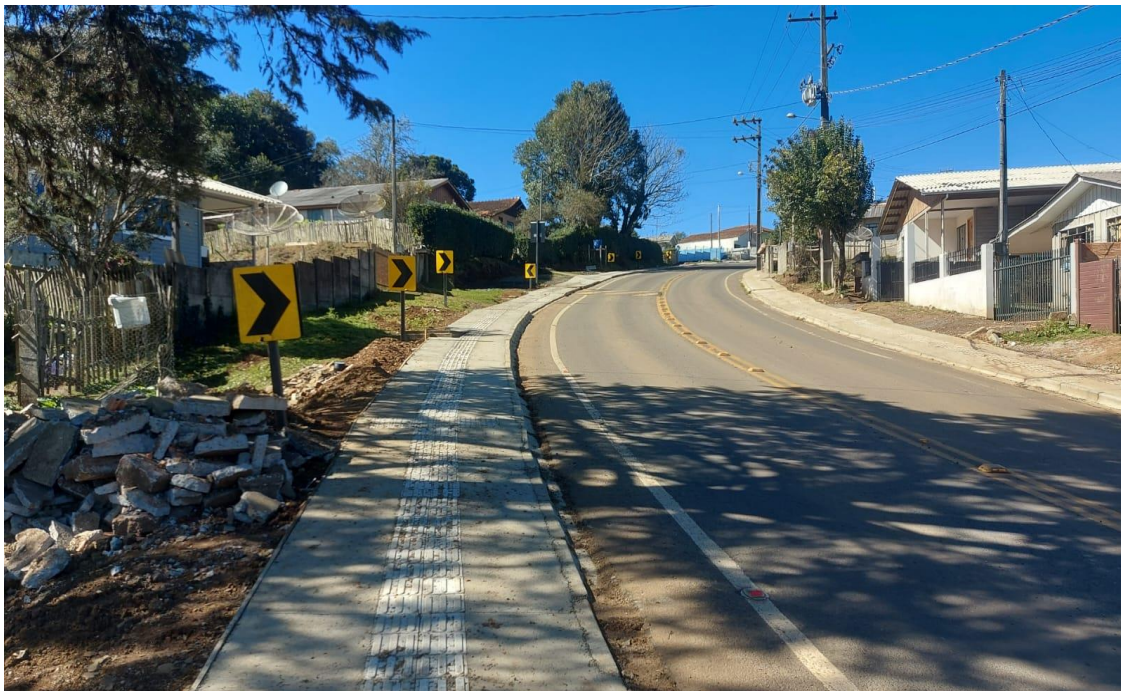
Imagem 9 – Calçadas em concreto e piso tátil
