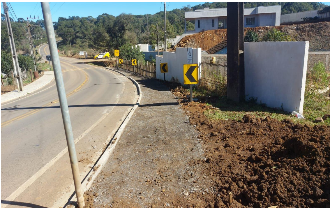
Imagem 04 – Lastro de brita e meio fio em concreto
