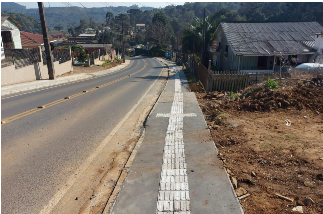
Imagem 10 – Calçadas em concreto e piso tatil
