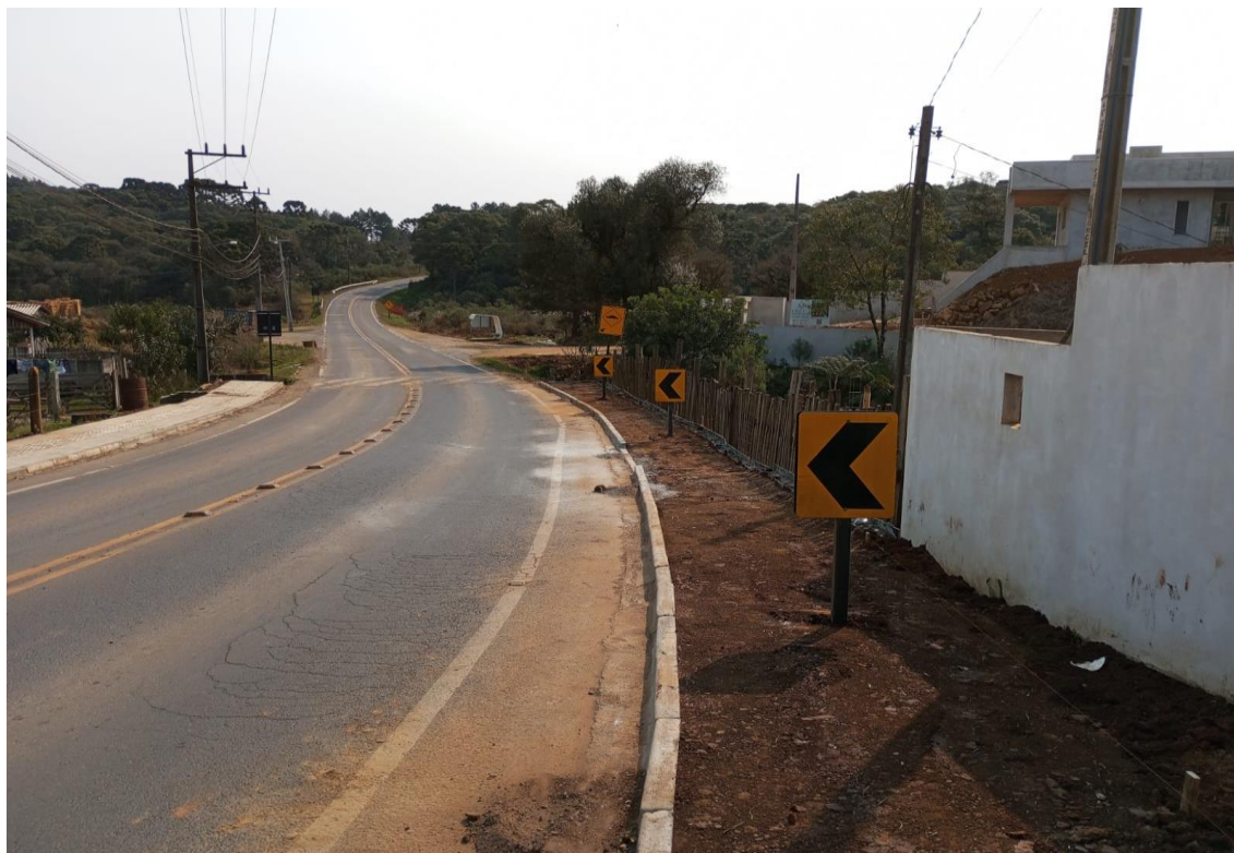
Imagem 03 – Regularização e compactação
