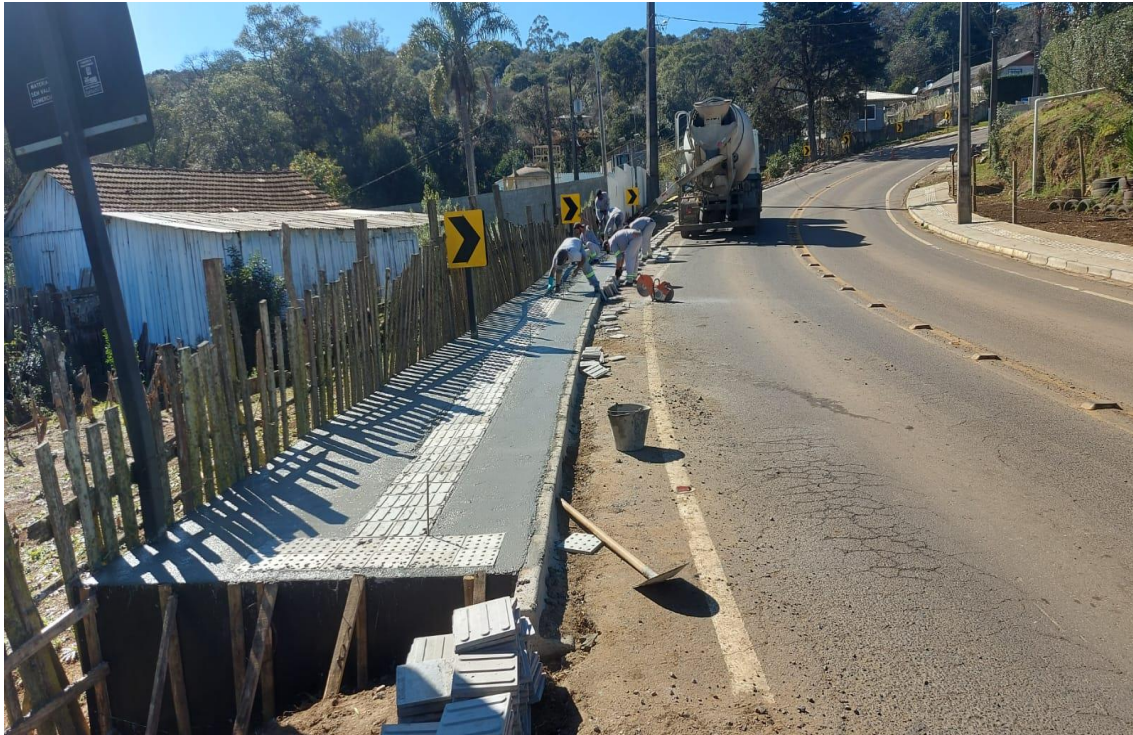
Imagem 08 – Calçadas em concreto e piso tátil
