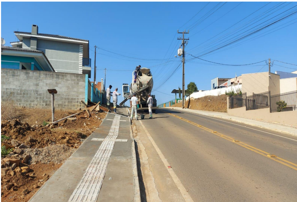
Imagem 11 – Calçadas em concreto e piso tátil
