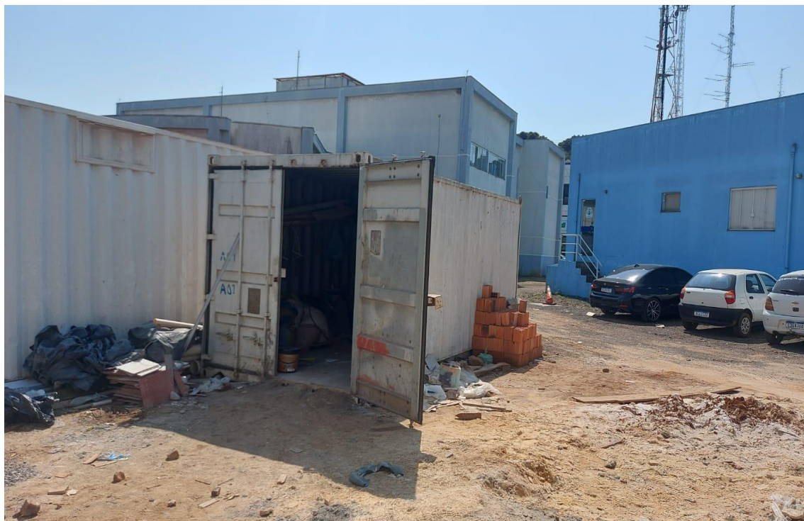
Imagem 03 – Locação de Container
