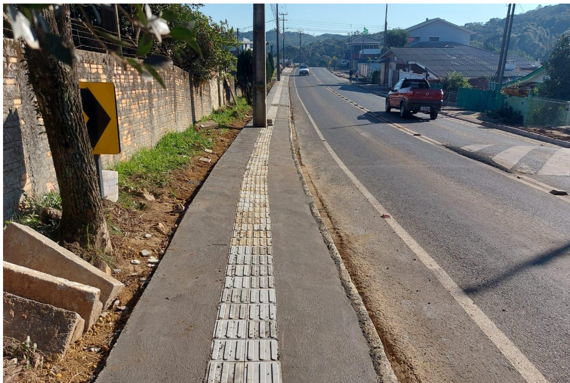
Imagem 09 – Calçadas em concreto e piso tátil
