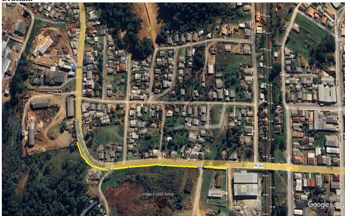
Imagem 01 – Foto aérea do local dos serviços de calçadas em concreto executadas – Rua Nair Bastos Druciaki
