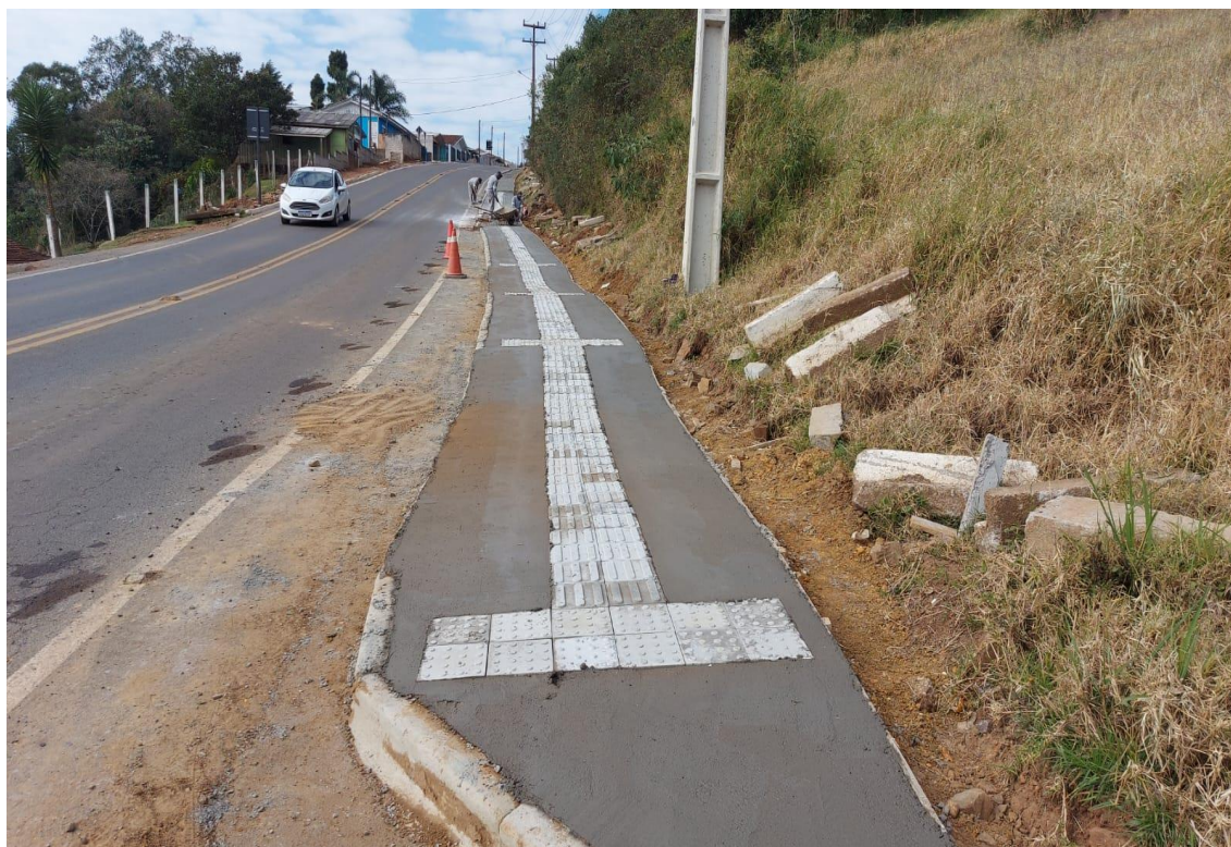
Imagem 11 – Calçadas em concreto e piso tátil
