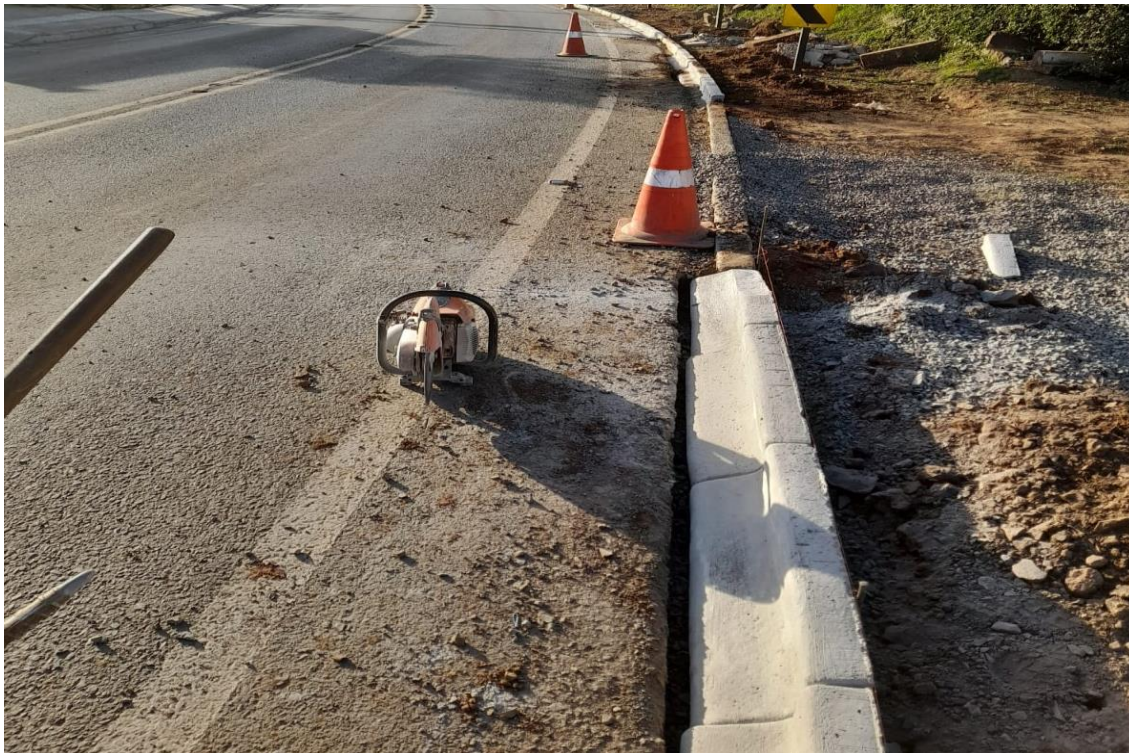
Imagem 02 – Meio fio em concreto
