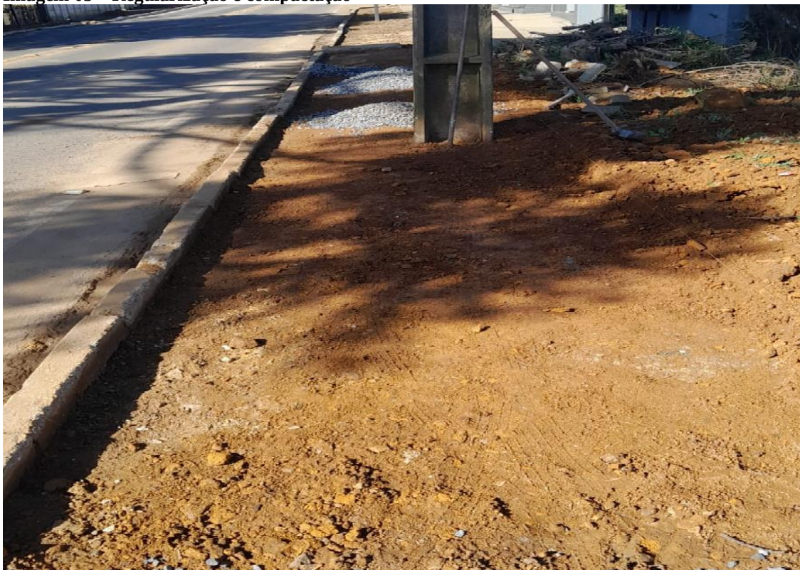
Imagem 03 – Regularização e compactação
