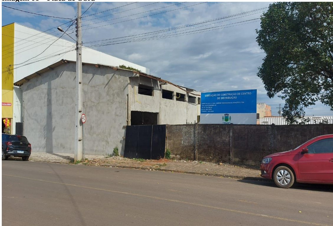
Imagem 01 – Placa de Obra
