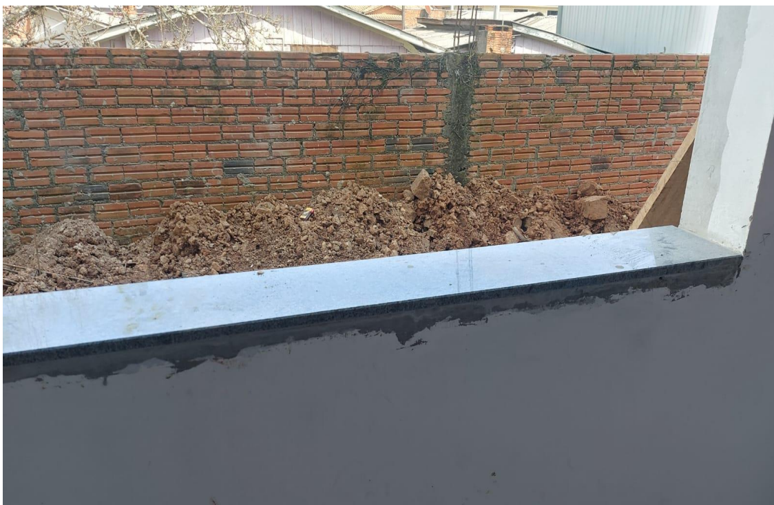
Imagem 05 – Peitoril em mármore/granito
