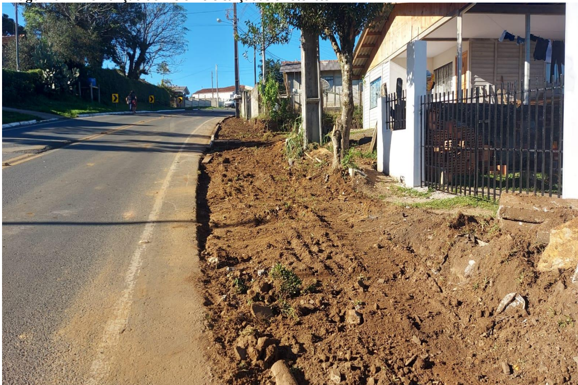
Imagem 04 – Demolição de meio fio e calçadas existentes
