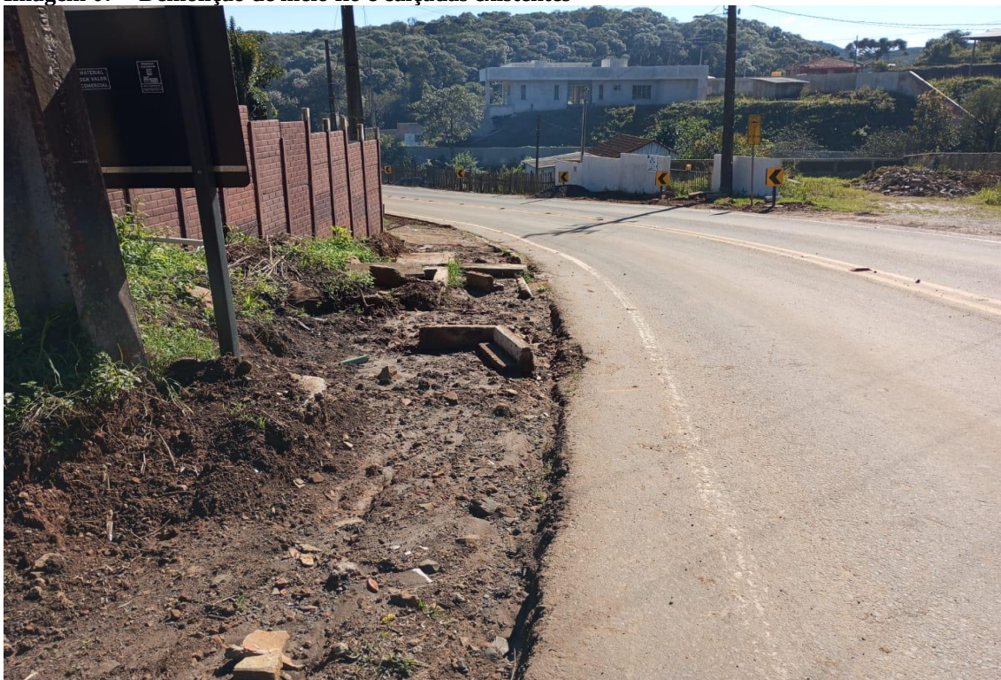
Imagem 07 – Demolição de meio fio e calçadas existentes
