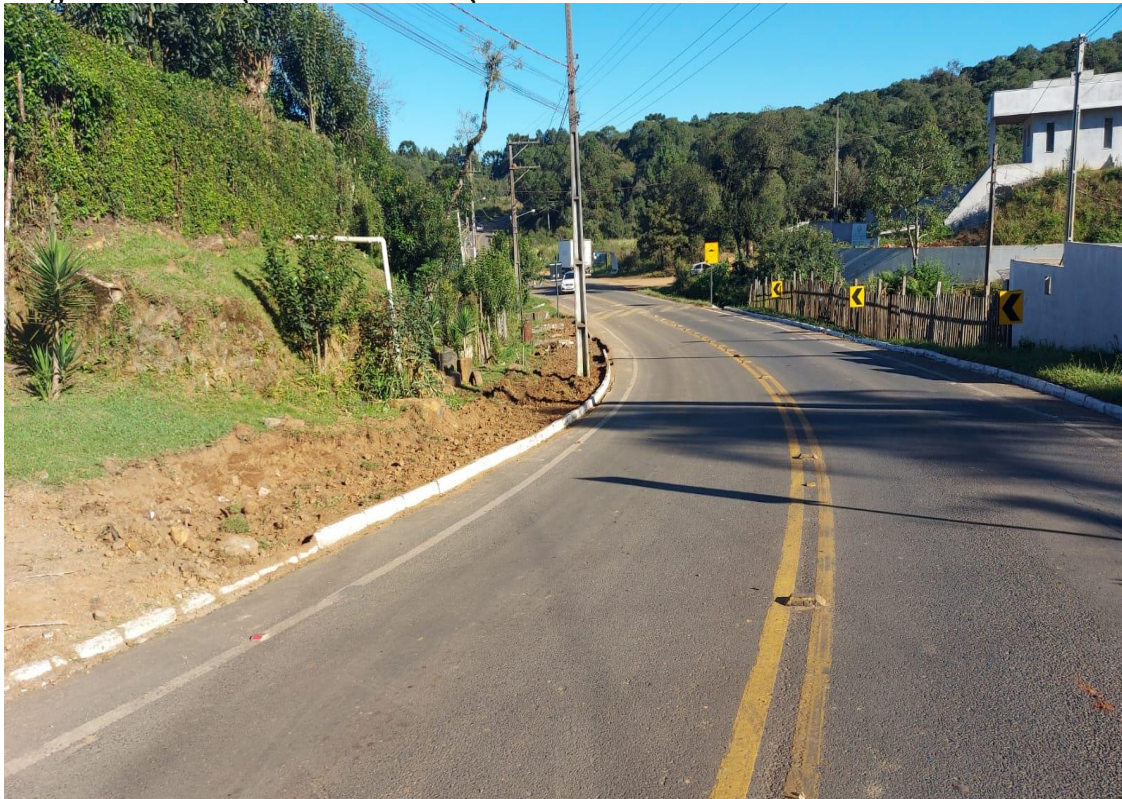
Imagem 05 – Demolição de meio fio e calçadas existentes
