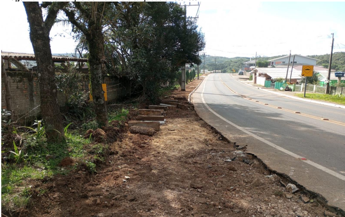
Imagem 03 – Demolição de meio fio e calçadas existentes
