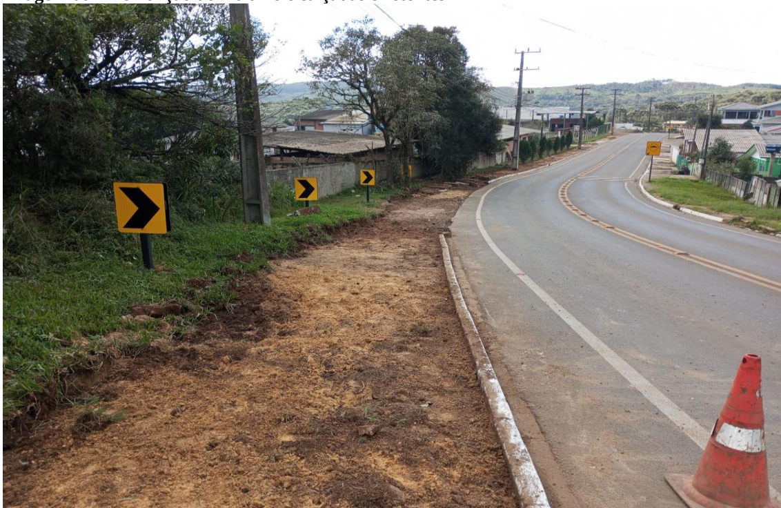
Imagem 07 – Demolição de meio fio e calçadas existentes
