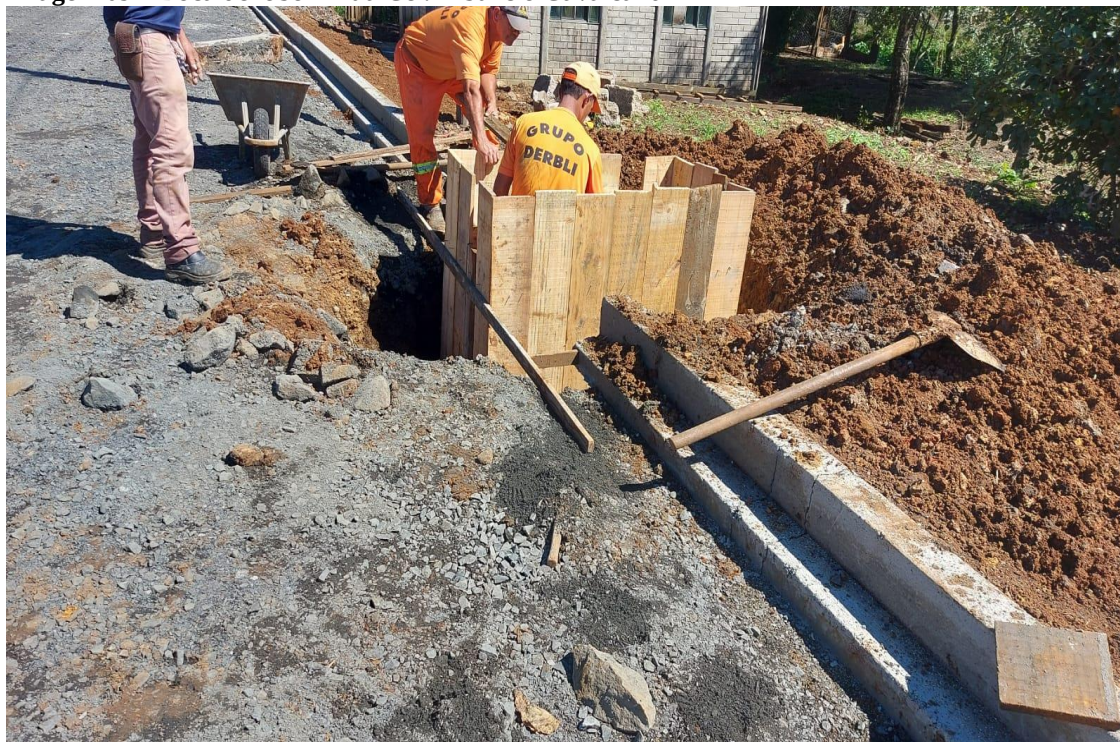
Imagem 09 – Boca de lobo – Rua Cel. Tiburcio Cavalcanti
