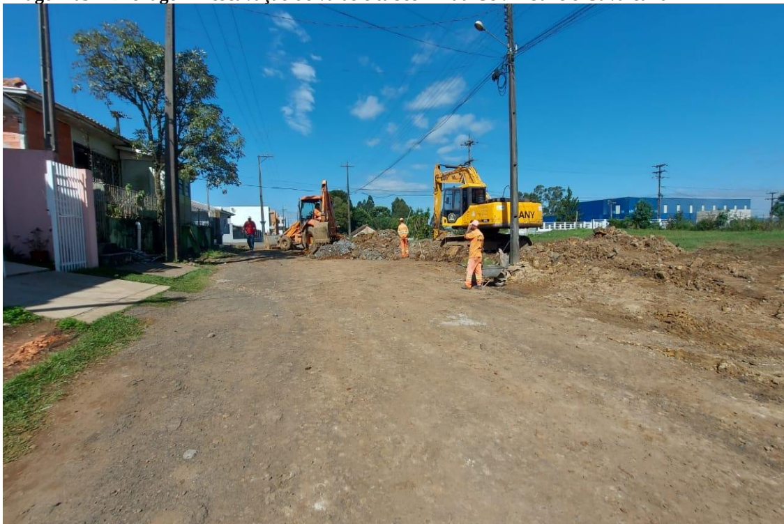
Imagem 05 – Drenagem – escavação de valas e tubos – Rua Cel. Tiburcio Cavalcanti
