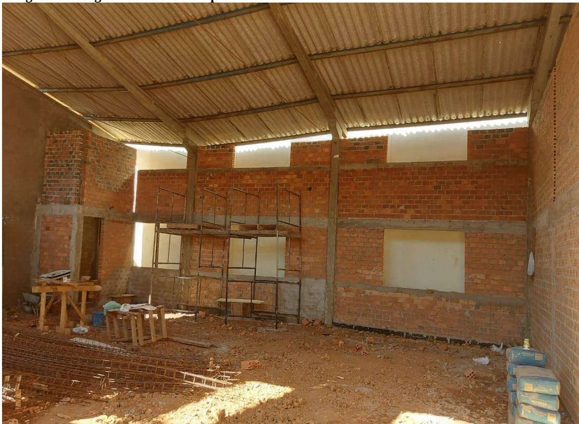
Imagem 09 – Vigas intermediária e pilares e alvenarias
