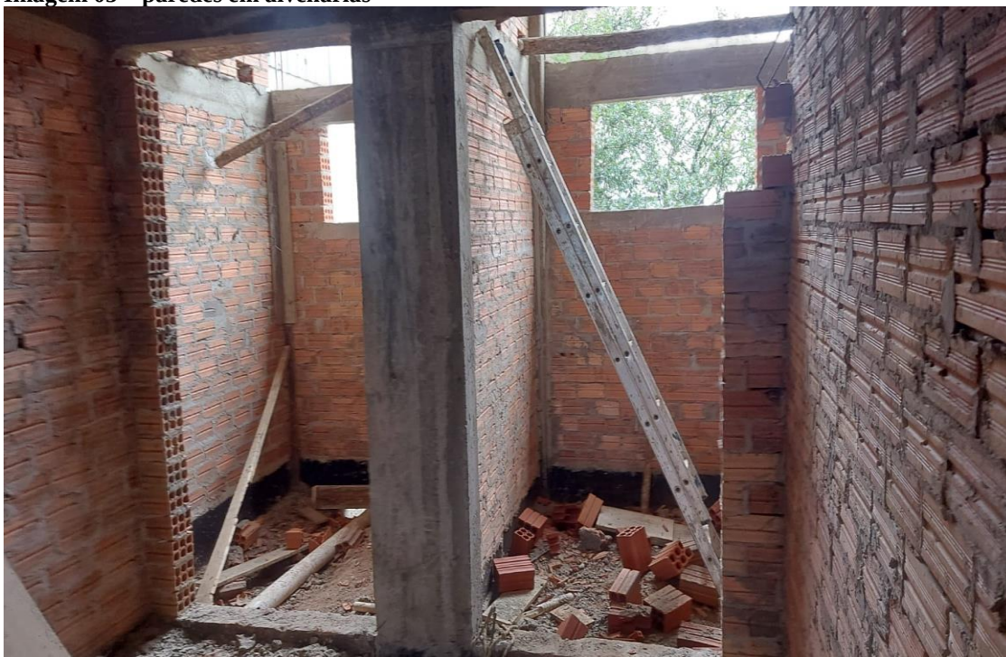
Imagem 05 – paredes em alvenarias
