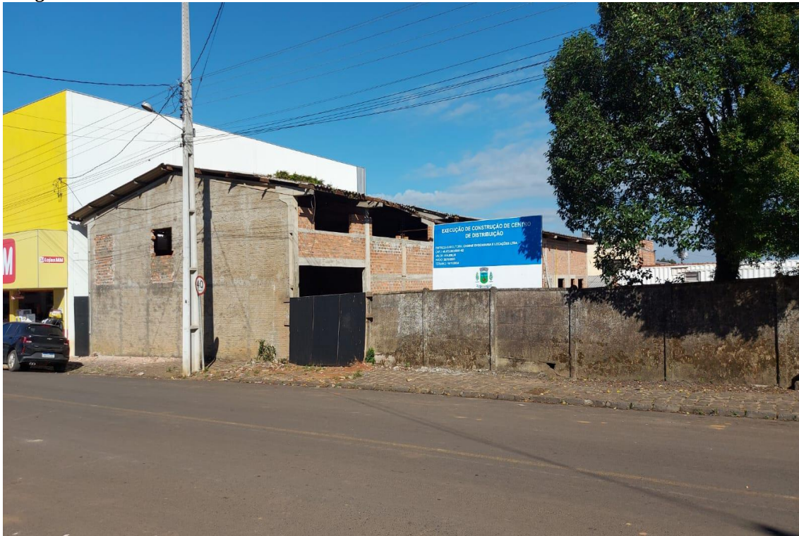
Imagem 01 – Placa de Obra
