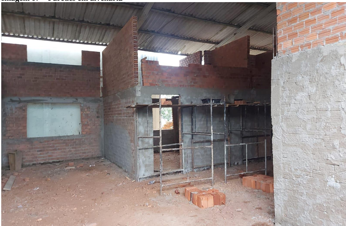
Imagem 07 – Paredes em alvenaria
