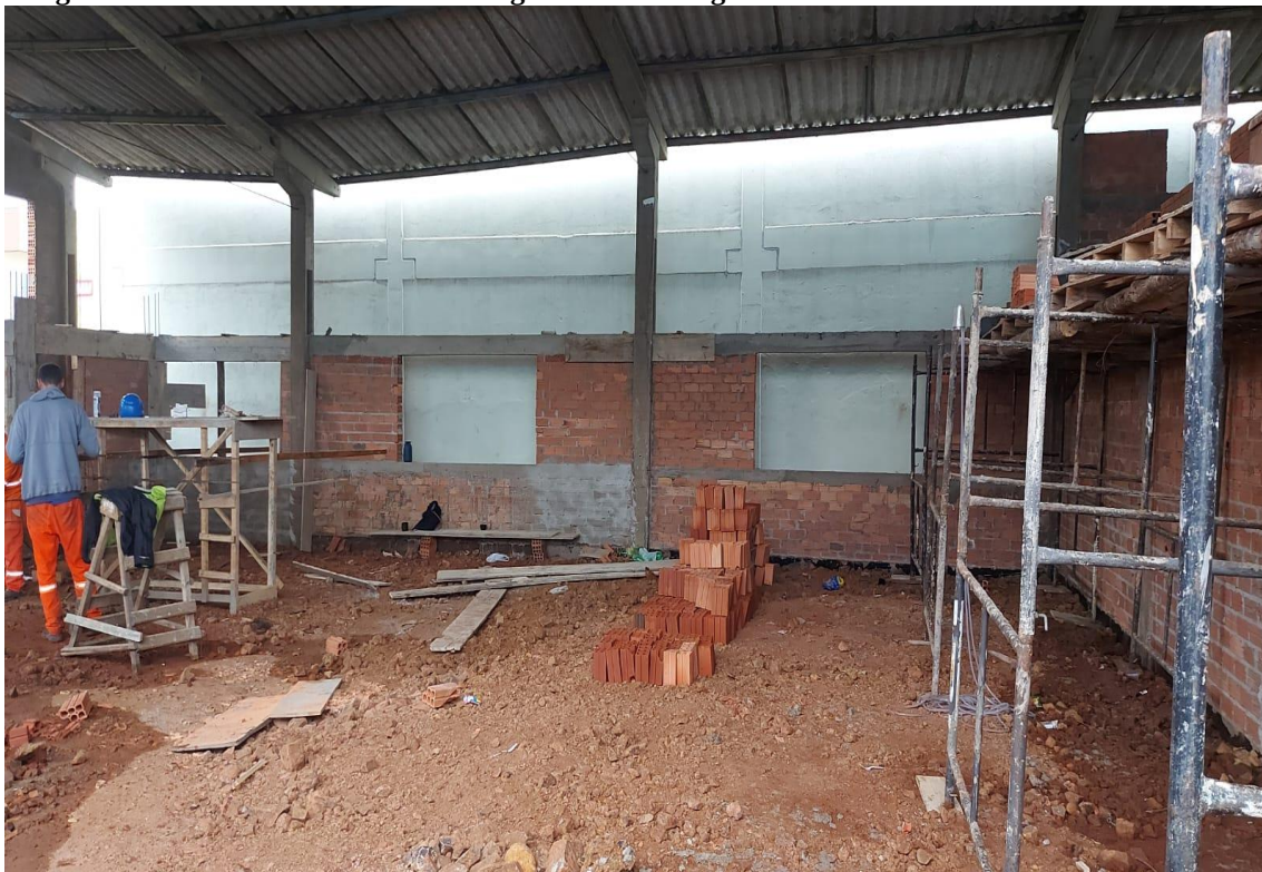
Imagem 06 – Paredes de alvenaria – vergas e contra vergas
