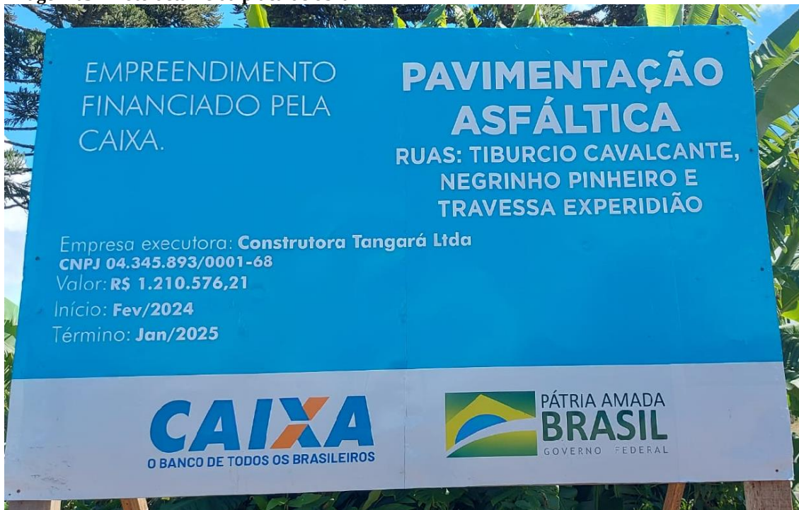
Imagem 03 – Foto detalhe da placa de obra
