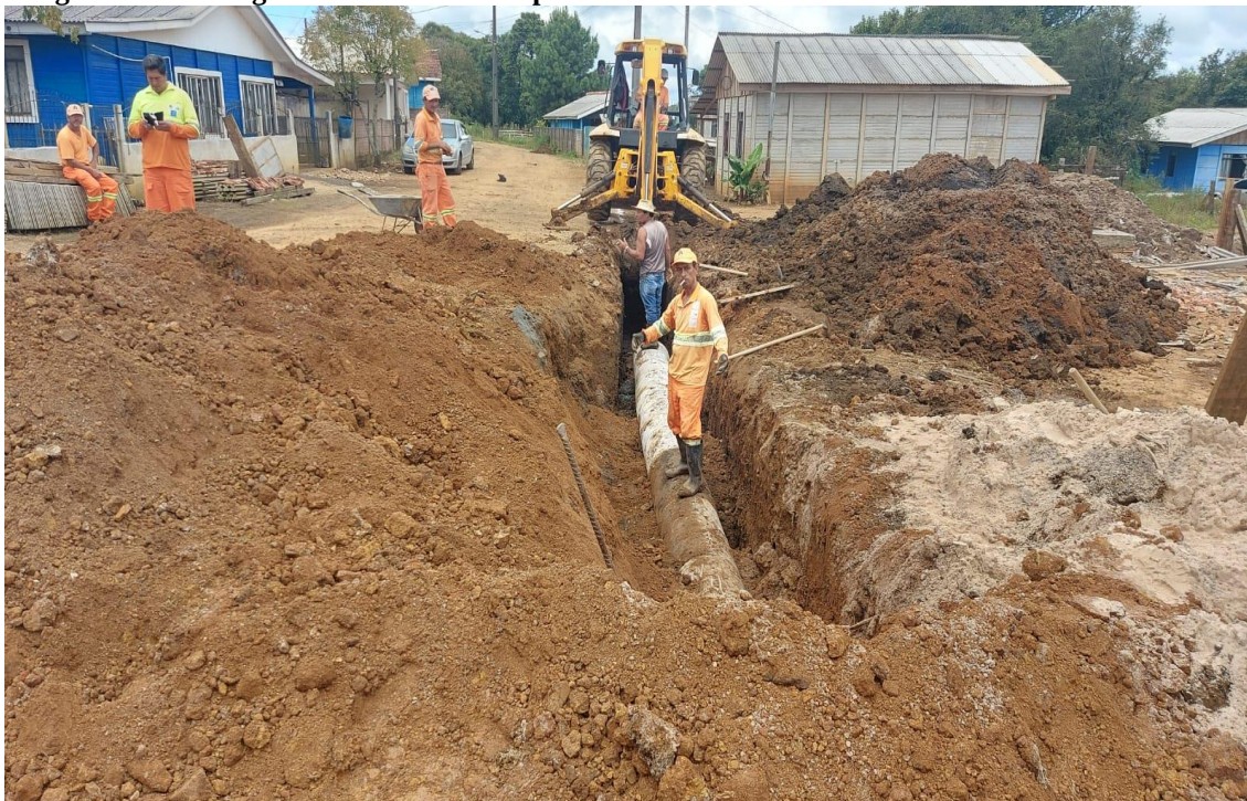
Imagem 06 – Drenagem – Reaterro de corpos de BSTC – Rua Cel. Tiburcio Cavalcanti
