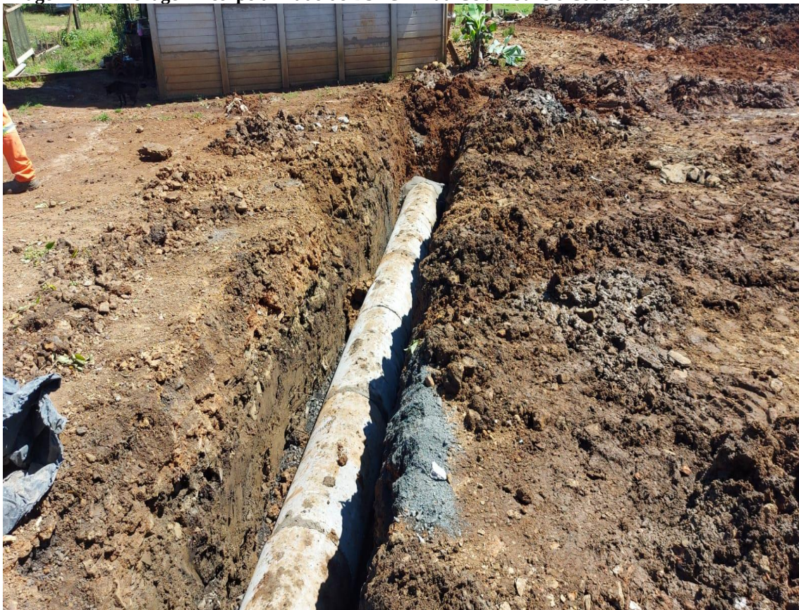
Imagem 07 – Drenagem - corpo armado de BSTC – Rua Cel. Tiburcio Cavalcanti
