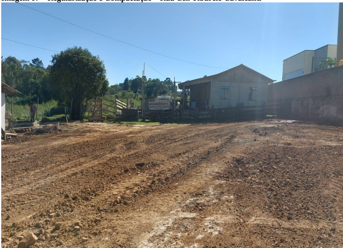
Imagem 07 – Regularização e Compactação – Rua Cel. Tiburcio Cavalcanti
