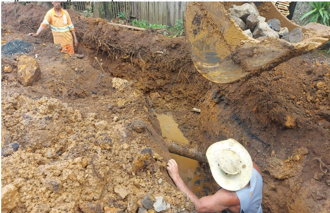
Imagem 05 – Drenagem – escavação de valas e tubos – Rua Cel. Tiburcio Cavalcanti
