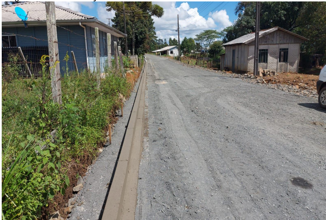
Imagem 17 – Meio Fio e Sarjetas – Rua Esperidião
