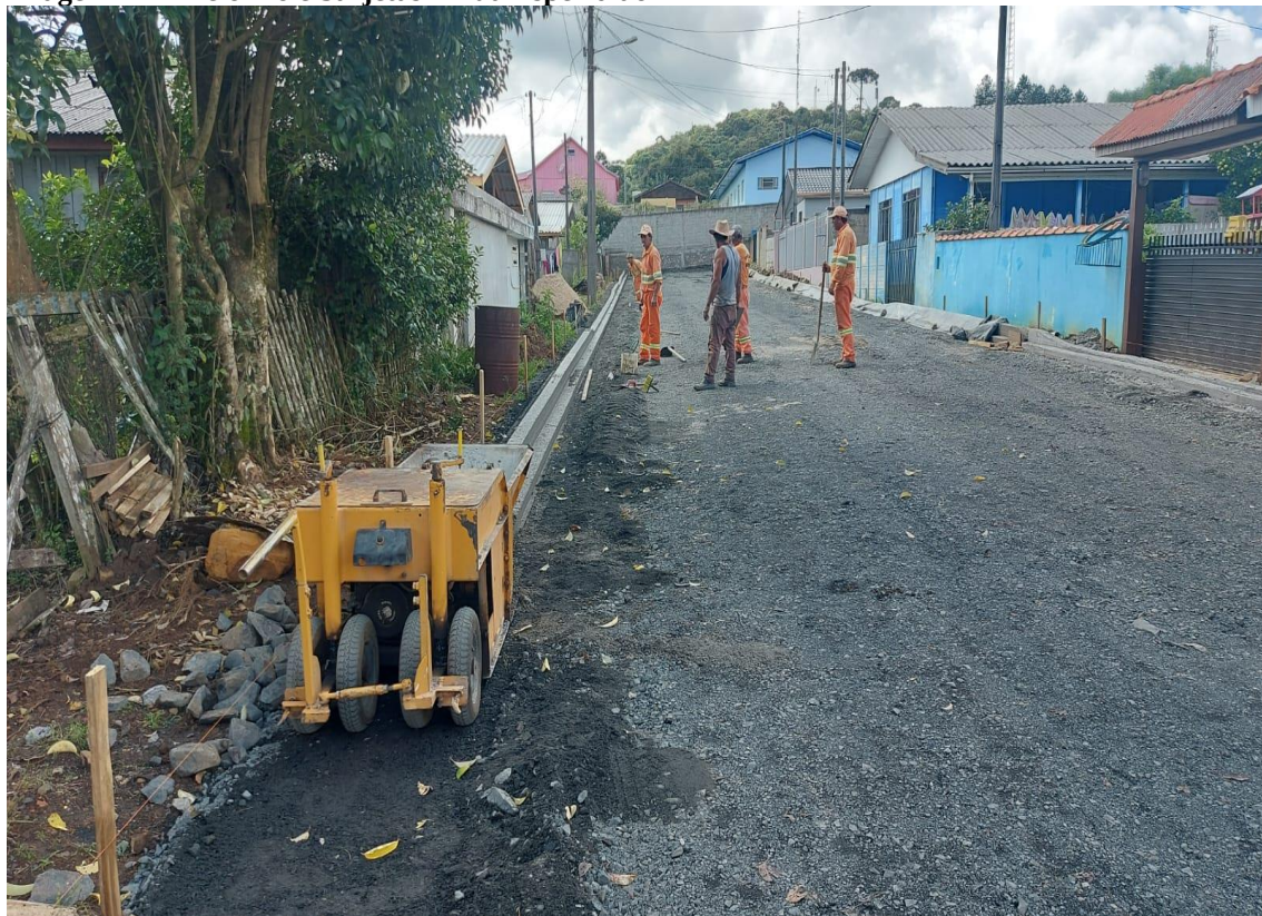
Imagem 17 – Meio Fio e Sarjetas – Rua Esperidião
