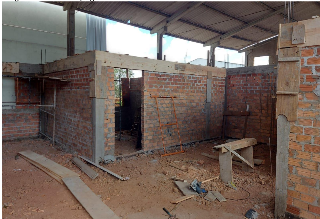
Imagem 10 – Alvenarias, vigas intermediárias
