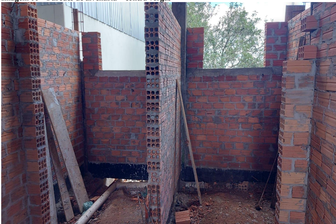
Imagem 06 – Paredes de alvenaria – contra vergas
