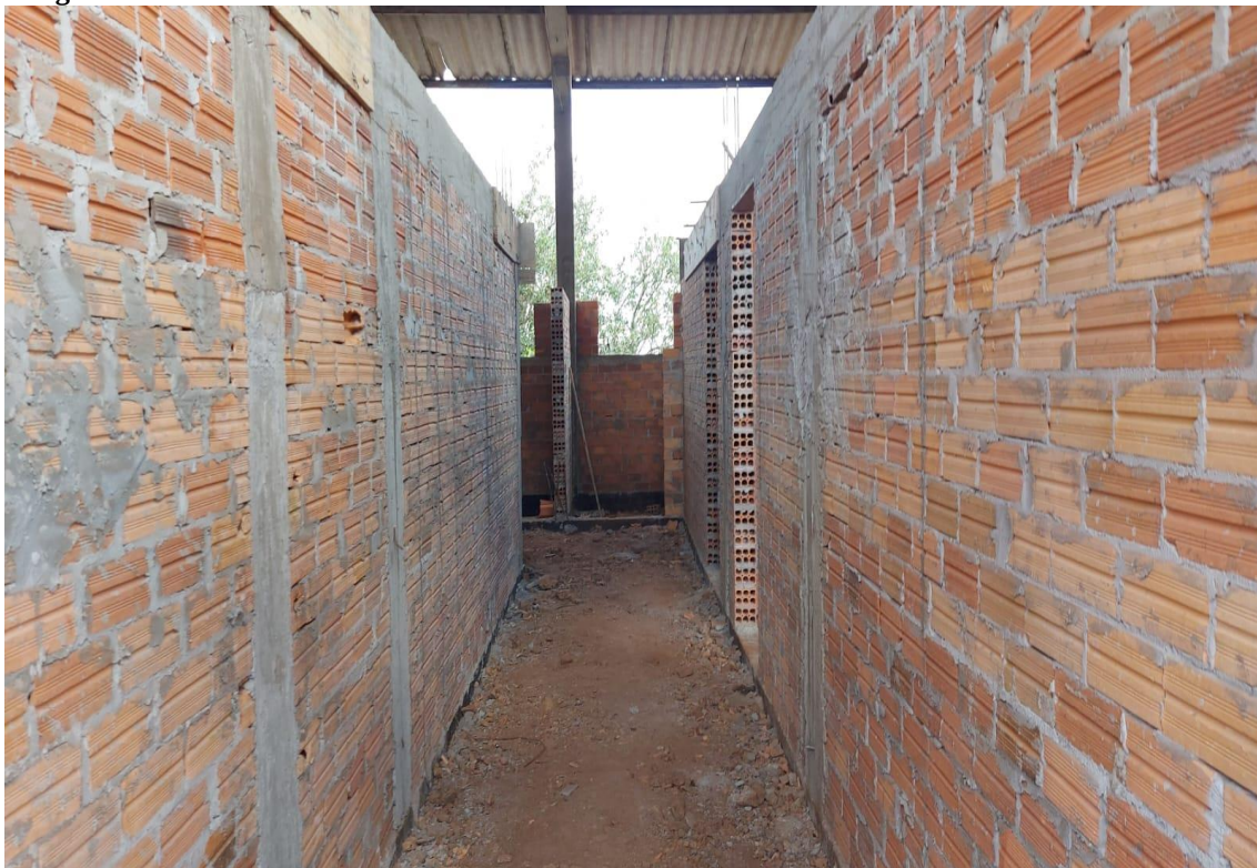
Imagem 07 – Paredes em alvenaria
