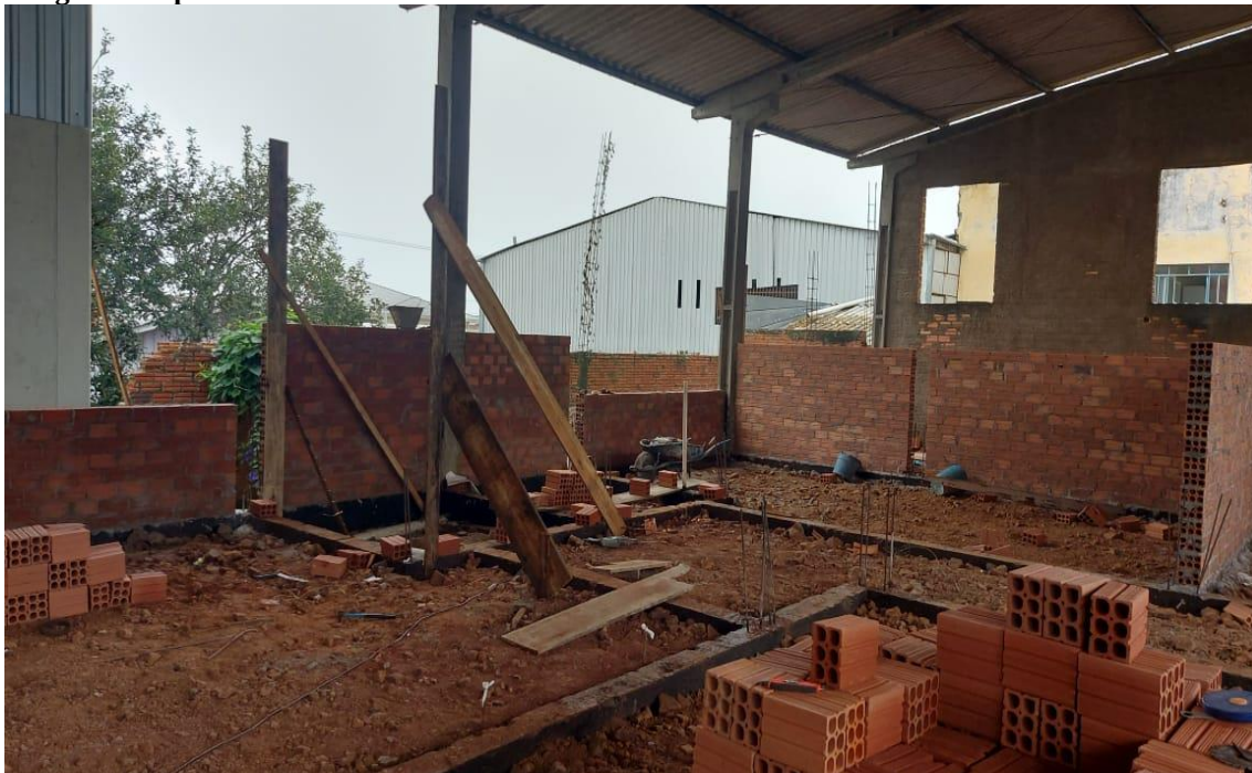
Imagem 05 – paredes em alvenarias
