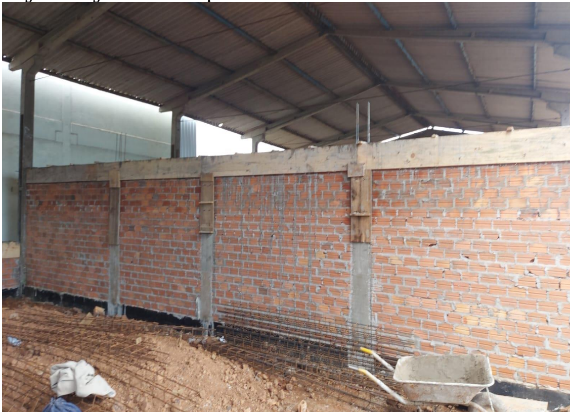
Imagem 09 – Vigas intermediária e pilares e alvenarias
