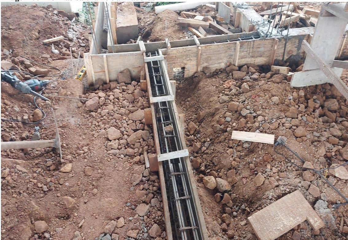
**Imagem 07 – Vigas em concreto e impermeabilização**
